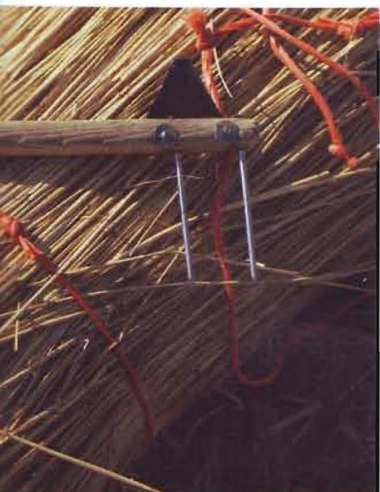
Links: Henk bedient de 'kammachine', die op een snelle manier de ruigte tussen het riet verwijderd. Rechts: Met deze grove kam wordt het riet 'gesloekt'.
