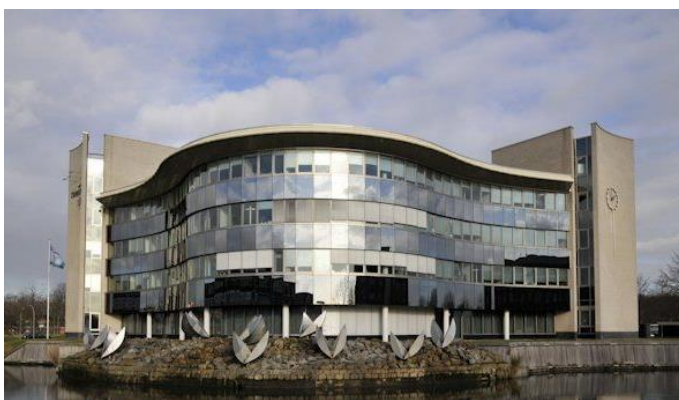
Het Waterschapshuis in Lelystad is ontworpen door Jan Hendrik Ruiter.
